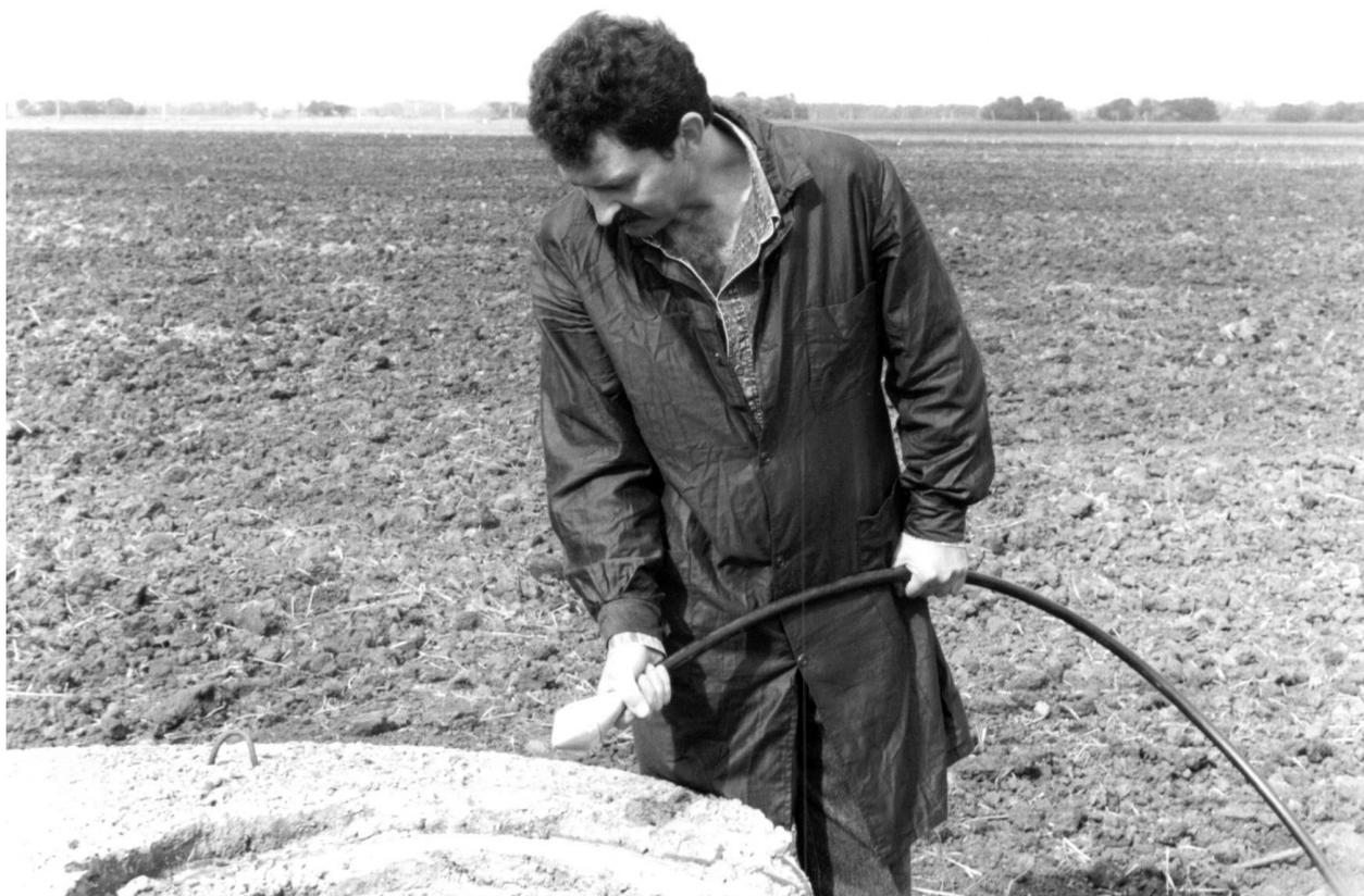
**Рис. 2.** Подача дренопромывочной головки в колодец
