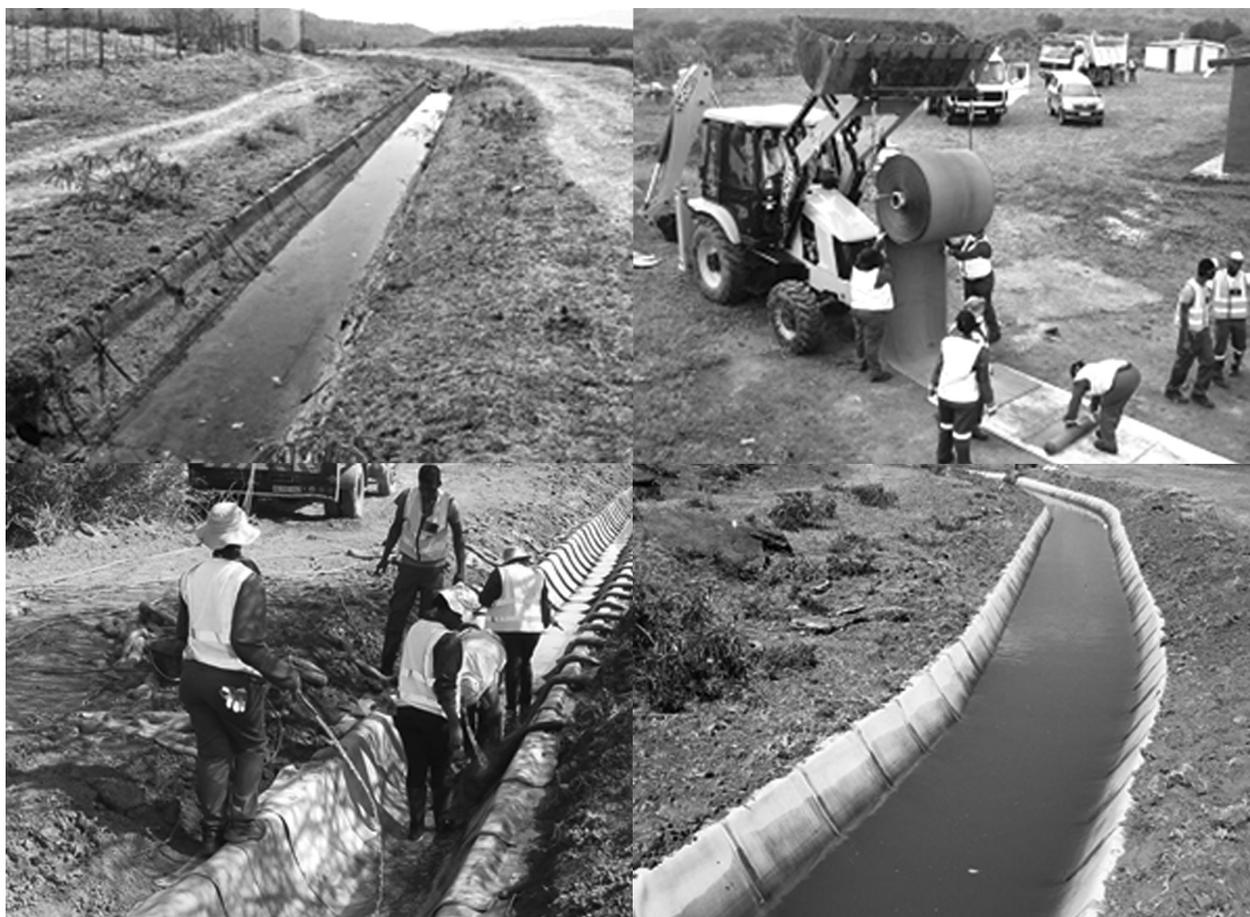
**Рис. 2.** Пример применения бетонного полотна на оросительных каналах
