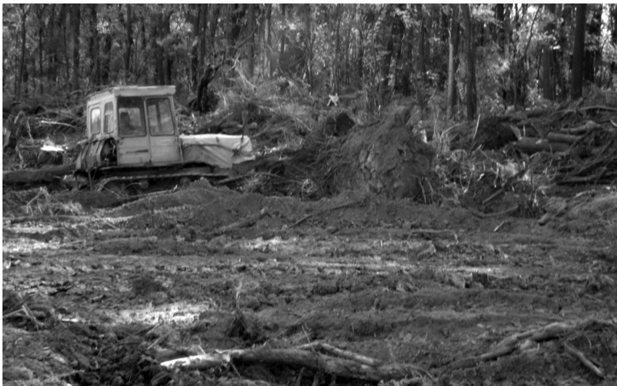
Рис. 4. Транспортировка пней в древесные валы
