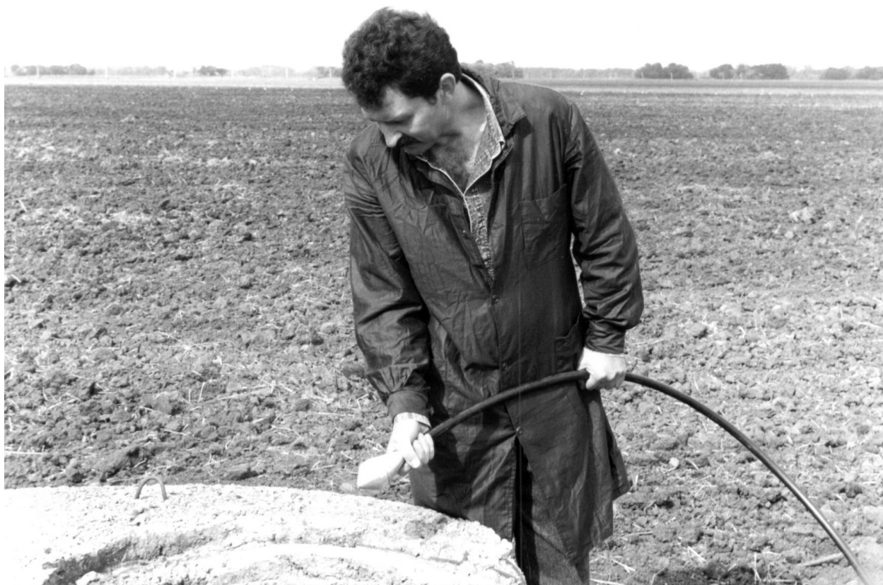
Рис. 2. Подача дренопромывочной головки в колодец
