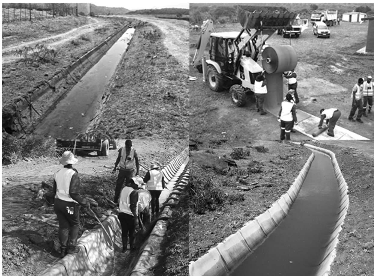
Рис. 2. Пример применения бетонного полотна на оросительных каналах
